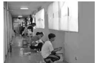
保護者と生徒が協力して、4棟1階 廊下北側の壁を塗っています。
